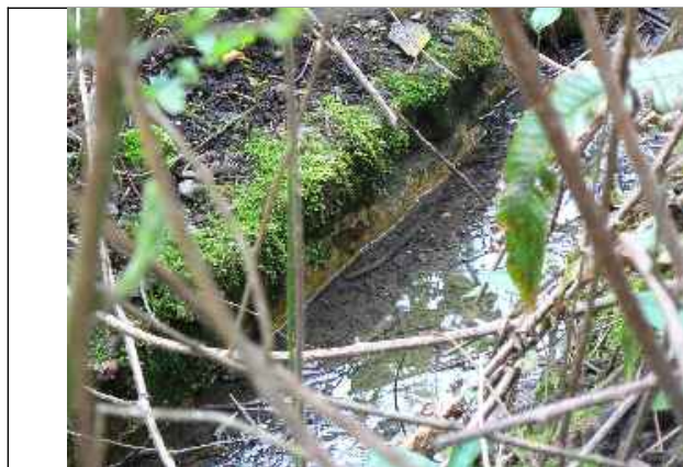
4. Rigole maçonnée pour l'écoulement latéral
