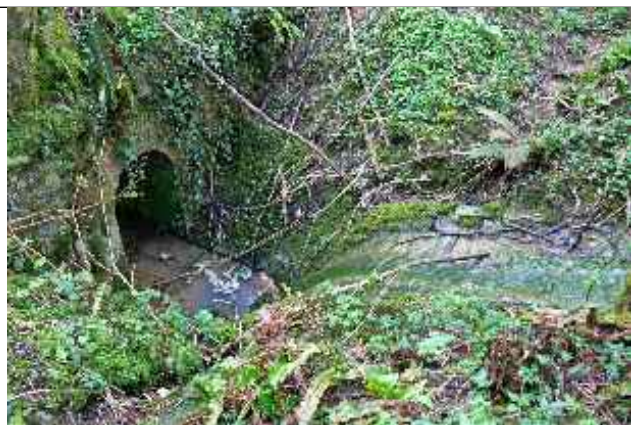
5. Ouvrage maçonné permettant l'évacuation de l'eau sous la voie
